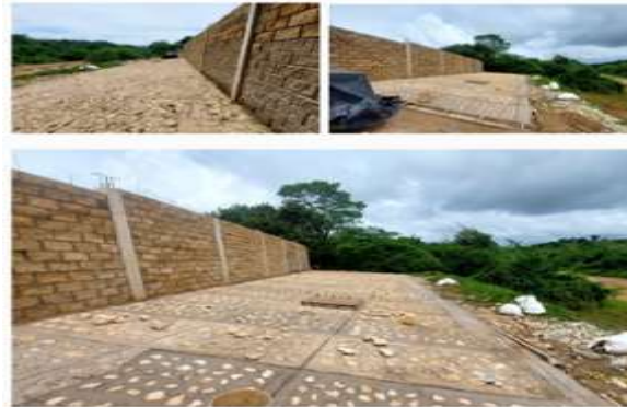
Imagen 39. Construcción enrocado costado lote Ebar.
