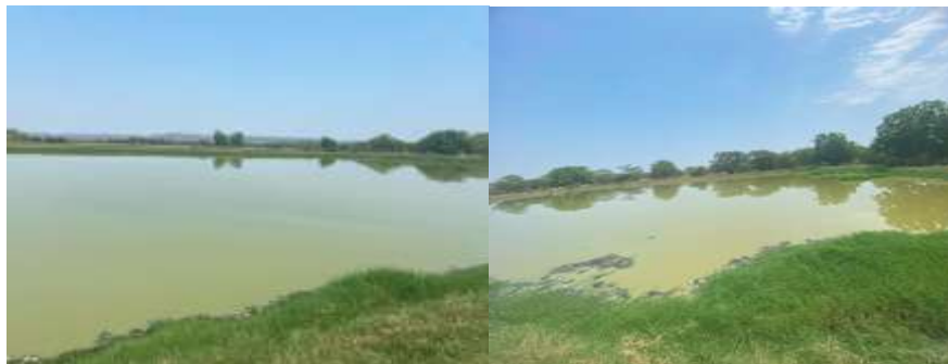
Imagen 36. Lagunas de oxidación, EDAR Manatí.
