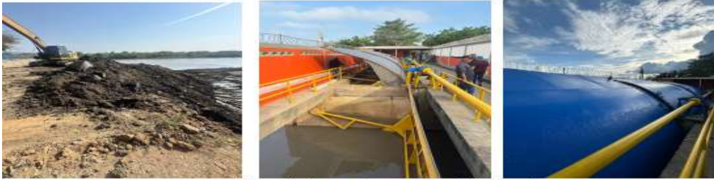
Mantenimiento Compuertas El Porvenir
