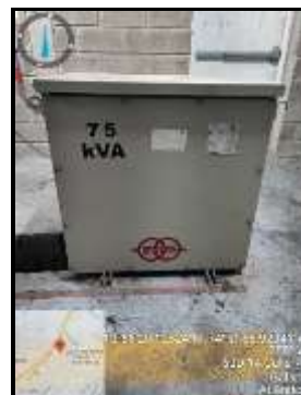
Imagen 138. Placa de características de equipo transformador que contiene aceite dieléctrico y Equipo transformador de 75kVA que opera con aceite dieléctrico.
