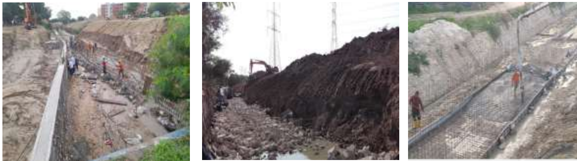
Imagen 176. Obras de recuperación ambiental del Arroyo El Platanal Ubicado en el Municipio de Soledad.
