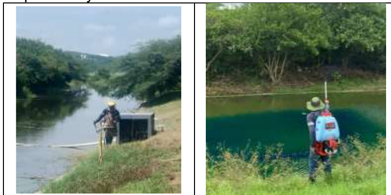
Imagen 18. Mantenimiento canal de biorremediación.
