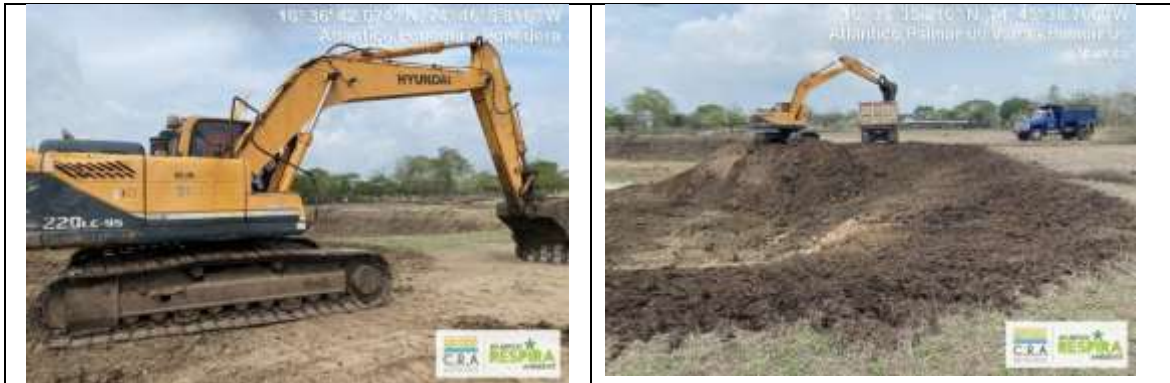
Actividades de Control, verificación documentación para actividades nivelaciones de terreno.
