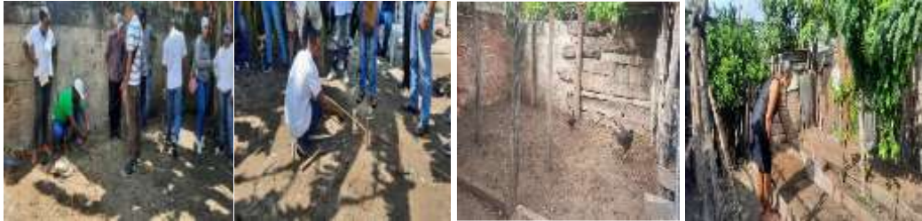
Imagen 156. Limpieza y adecuación de espacios para Eco huertas.
