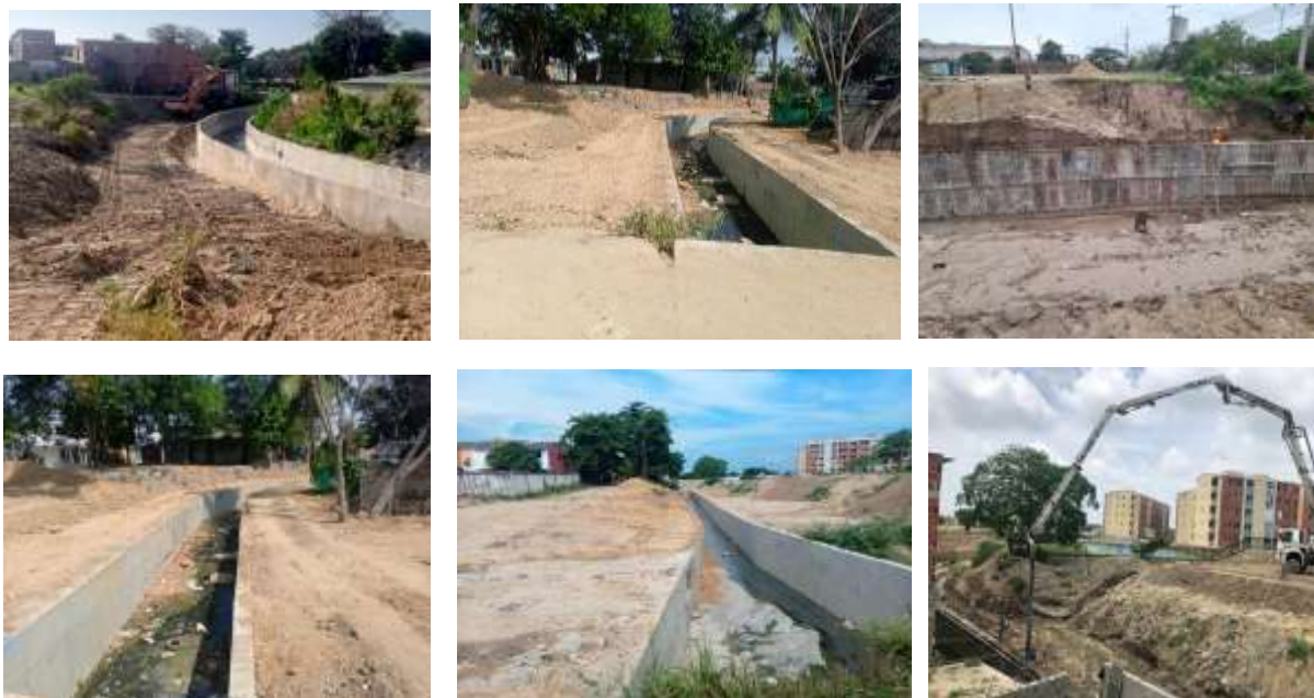
Imagen 177. Obras de recuperación ambiental del Arroyo El Platanal Ubicado en el Municipio de Soledad.
