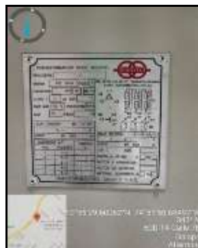
Imagen 138. Placa de características de equipo transformador que contiene aceite dieléctrico y Equipo transformador de 75kVA que opera con aceite dieléctrico.
