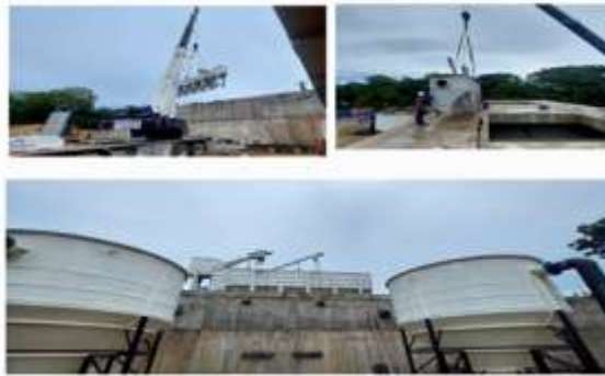
Imagen 40. Montaje equipo cribado en reactor UASB.
