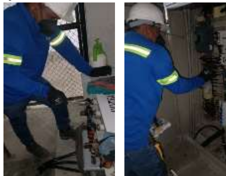
Imagen 204. Intervención preventiva del transformador eléctrico de la sede principal.
