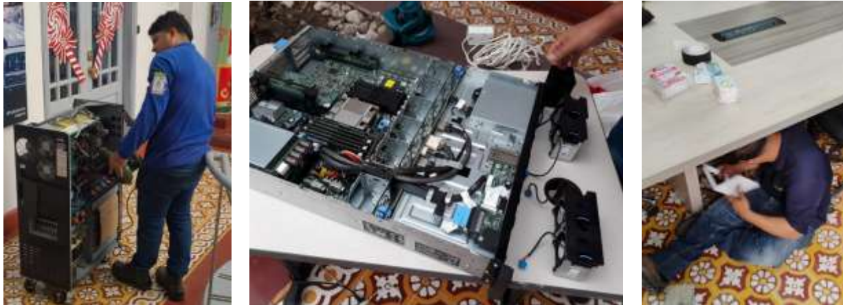
Imagen 185. Ejecución del Programa Anual de Mantenimiento de Tecnologías de la C.R.A.
